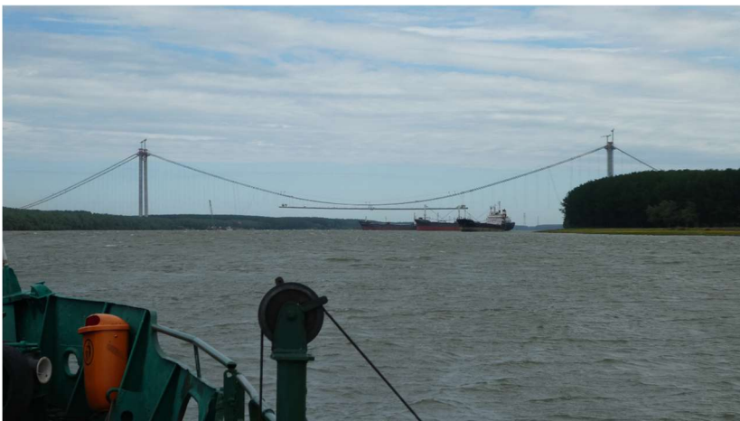
Die neue Donaubrücke im Entstehen
